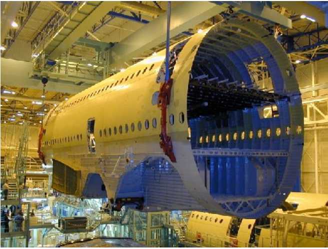
Le tronçon du A380 a deux étages
